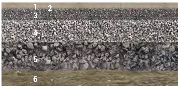
Abbildung 4: Aufbau gebundene Bauweise (Oberbau 1–5)
